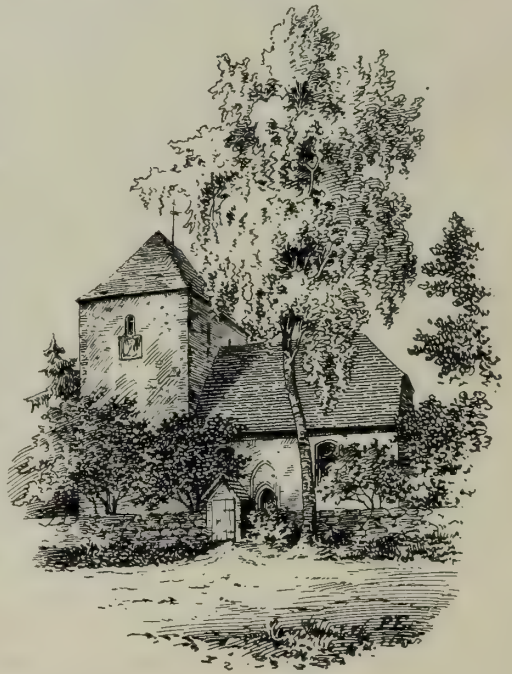
Fig. 233. Schweinrich. Ansicht der Kirche von Süden.
